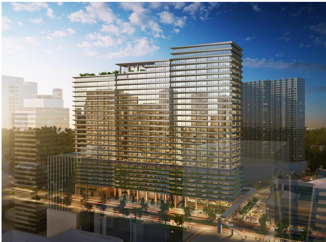
【The Yuchengco Centre 外观渲染图（日建设计提供图片）】
