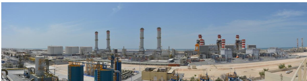
< 火力发电及海水淡化设备 >
